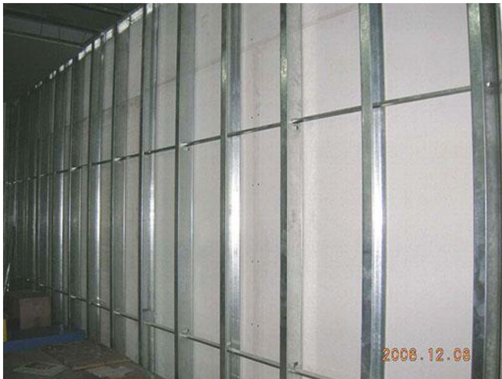
隔墙安装示意图
